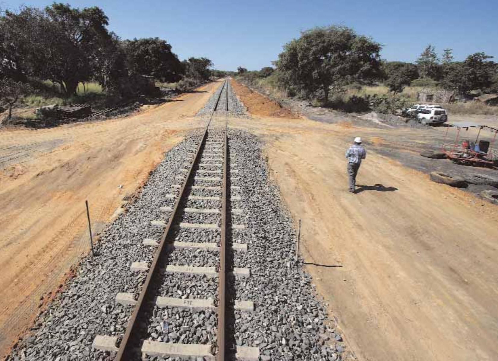
realizando os trabalhos de preparação, nomeadamente a desmontagem da linha férrea, a depuração do balastro, e a preparação da plataforma, entre outras intervenções que vão permitir que a montagem da nova linha seja acelerada.
