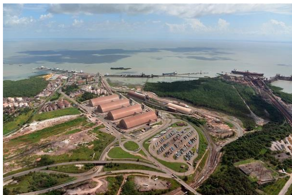
Porto do Itaqui 2 Terminais no Porto de Itaqui (MA). Foto: Divulgação.
