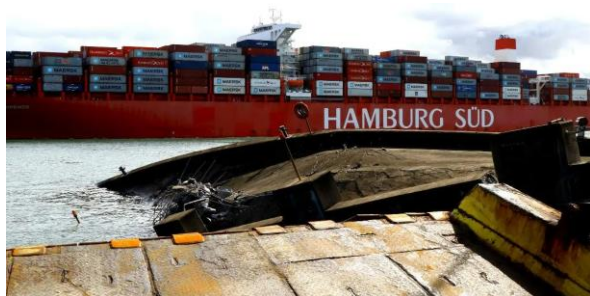
Uma das estruturas utilizadas para a atracação das balsas em Guarujá acabou destruída pelo navio Foto: Vanessa Rodrigues/AT
