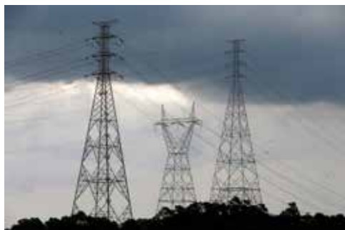
Torres de transmissão de energia perto da represa de Diadema
