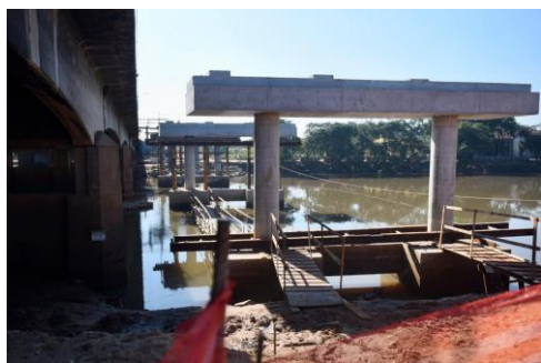
Obras estão no sentido capital para o interior do Rio Grande do Sul Crédito: Ricardo Botelho/MInfra
